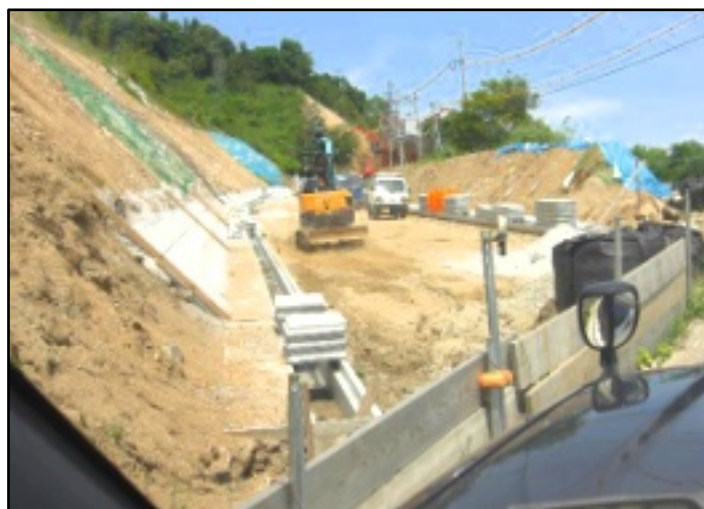
大々的に進む中国電力の道路拡幅工事
