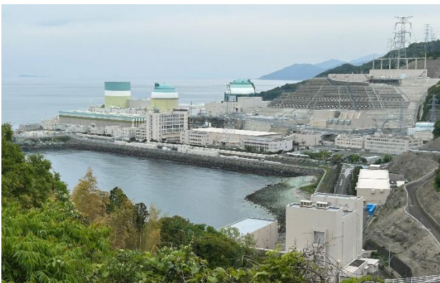
写真4 伊方原発 左から廃炉の1・2号機、稼働3号機
